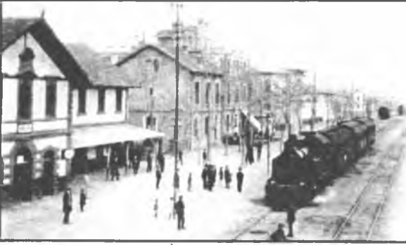
Resim 7. Gar ve İstasyon Binası, Bir Zamanlar Ankara , Ankara Büyük Şehir Belediyesi Yayınları.
