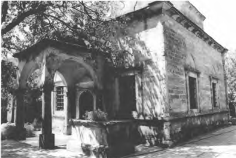
Murad Hüdavendigâr türbesi 2004 yılında restorasyon öncesi
