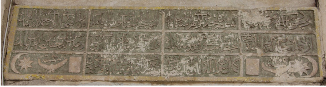
Fotoğraf 2.13. Cenabi Ahmet Paşa Camii, Taç kapının batısında pencere üzerinde bulunan onarım kitabesi
