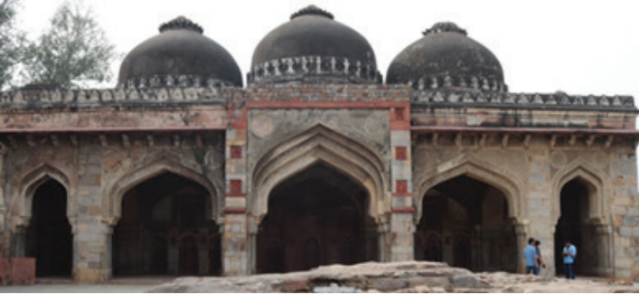
Foto. 11 – Cuma Camii Doğu Cephe (Can, 2019)
