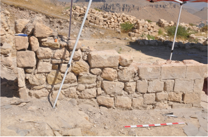
AG 12 Amasında Yer Alan D16 Duvarı Restorasyon Öncesi
