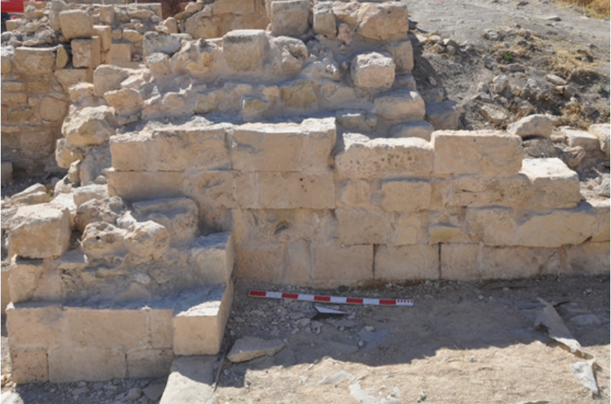
AH 13 Amasında Yer Alan D29 Duvarı Restorasyon Sonrası
