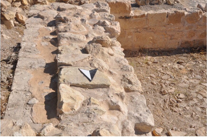
AH 13 ve AH 14 Amalarının Kesiřiminde Yer Alan D1 Duvarı Restorasyon Sonrası
