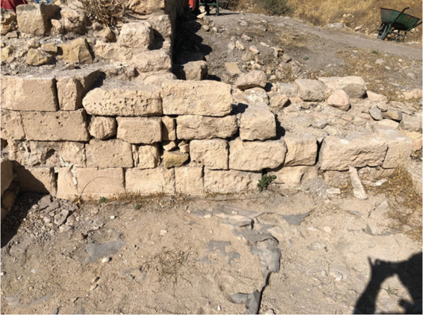
AH 13 Amasında Yer Alan D29 Duvarı Restorasyon Öncesi
