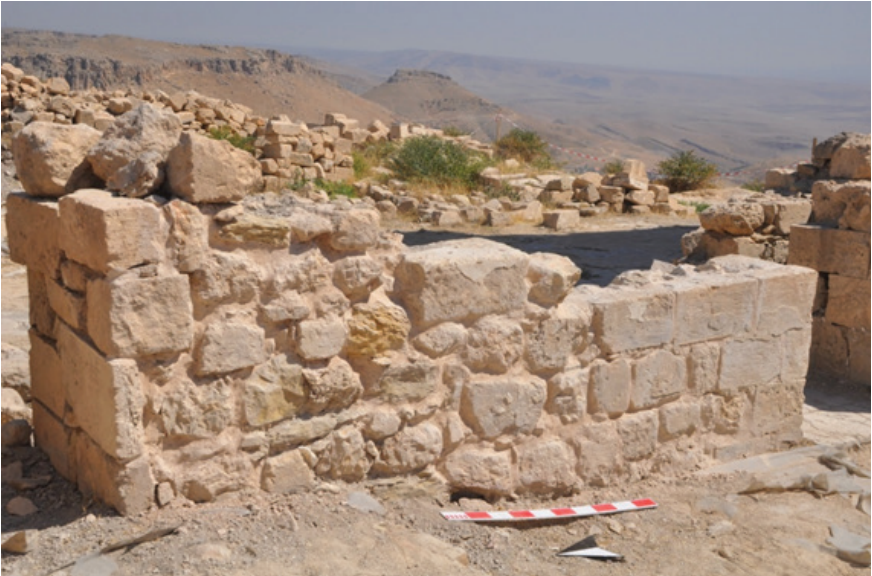
AG 12 Amasında Yer Alan D16 Duvarı Restorasyon Sonrası
