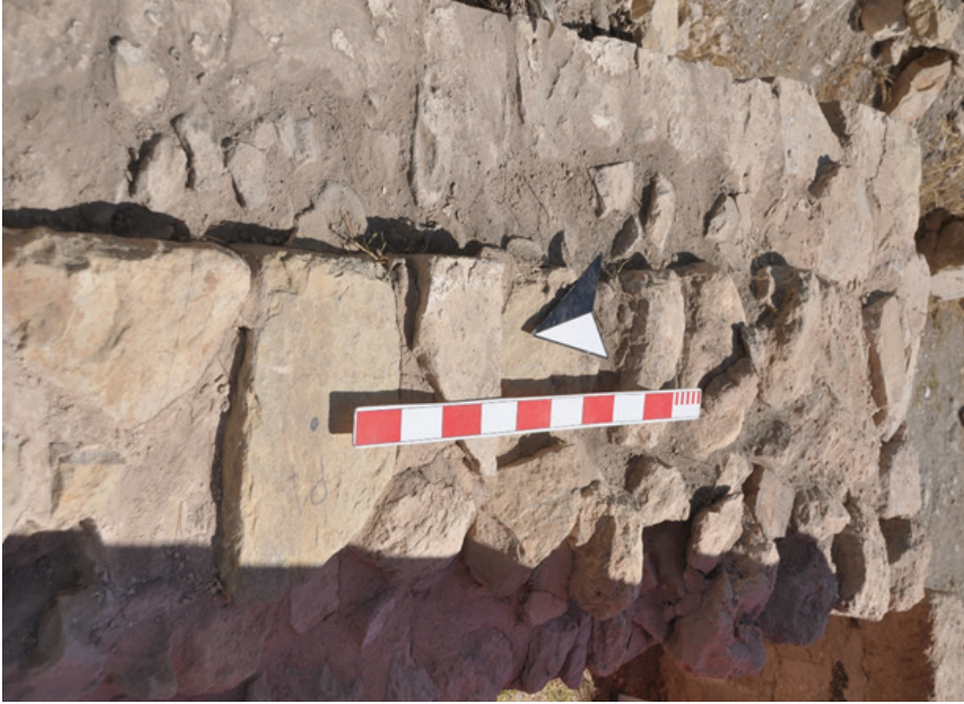
AH 13 ve AH 14 Açmalarının Kesişiminde Yer Alan D1 Duvarı Restorasyon Öncesi
