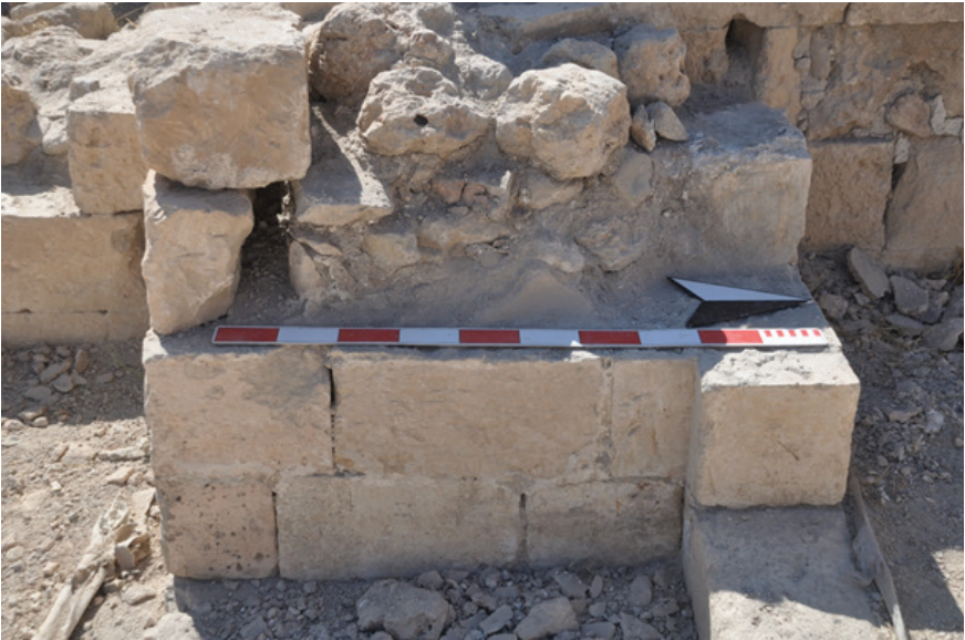
AH 13 Amasında Yer Alan D29 Duvarı Restorasyon Öncesi
