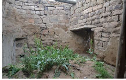
Foto 9: Güney ve Batı Cephe
