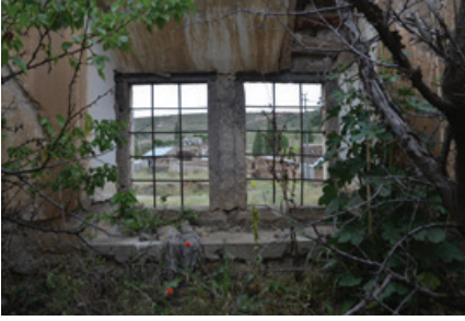
Foto 32: Doğu Cephedeki Pencere Detayı
