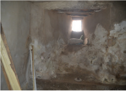
Foto 50: Batı Cephedeki Pencere Detayı
