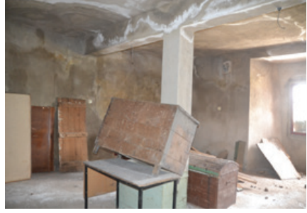
Foto 53: Batı ve Güney Cephesi Genel Görünüş
