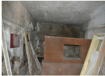
Foto 51: Güney Cephe Detayı
