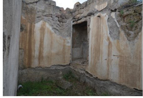
Foto 39: Kışlık Oda Batı ve Güney Cephe Görünüşü
