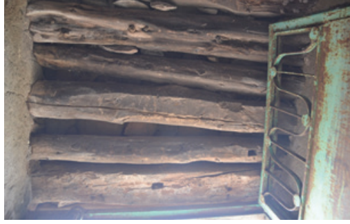
Foto 47: Aralığın Orijinal Hezen Üst Örtüsü
