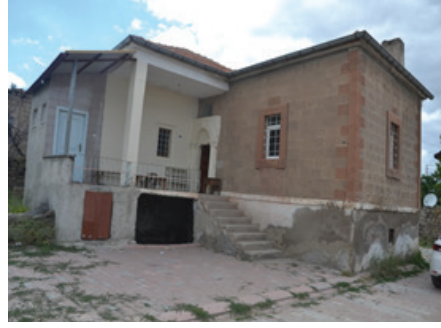
Foto 71: Yapının Genel Görünüşü
