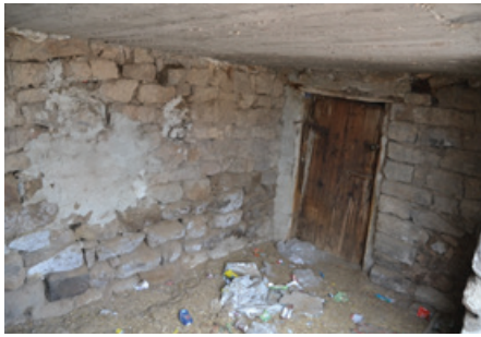
Foto 73: Yapının Ahır Bölümü
