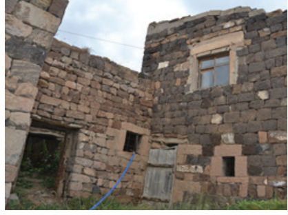
Foto 3: Odanın Doğu Cephe Görünüşü
