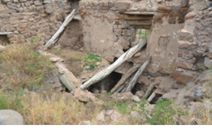
Foto 4: Odanın Üst Örtüsü ve Batı Cepheden Görünüşü
