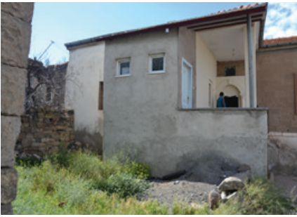
Foto 72: Yapının Güney Cephesi
