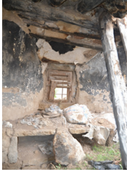
Foto 17: Doğu Cephedeki Pencere Detayı
