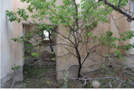
Foto 34: Yazlık Oda Kuzey Cephe
