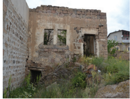
Foto 27: Yapının Doğu Cephesi
