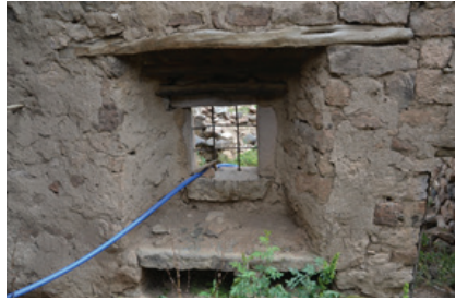
Foto 7: Doğu Cephedeki Pencere Detayı
