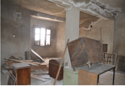
Foto 52: Odanın Batı Cephesi
