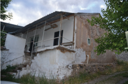
Foto 57: Doğu ve Kuzey Cephe
