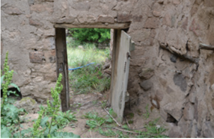
Foto 6: Oda Giriş Kapısı
