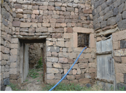
Foto 2: Doğu Cephe ve Giriş Kapısı
