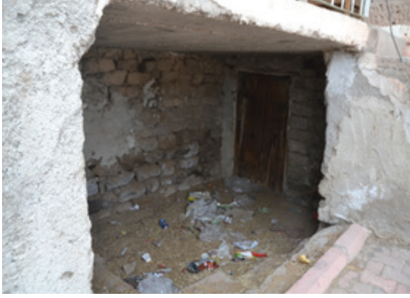
Foto 74: Yapının Ahır Bölümü
