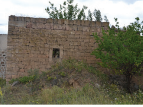
Foto 28: Yapının Kuzey Cephesi
