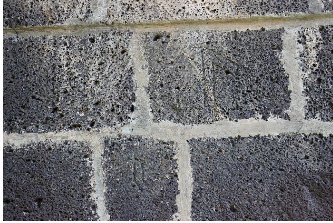
Fotoğraf 1- Diyarbakır Cümeck Köprüsü'nde Taşçı İşaretleri
