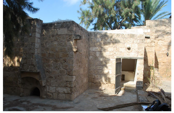
Foto. 34: Şömineli Ev Hamamı, doğu cephe.
