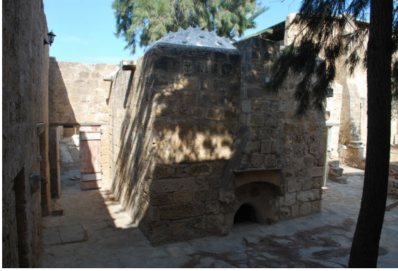
Foto. 35: Şömineli Ev Hamamı, ocak ve yaşmak.
