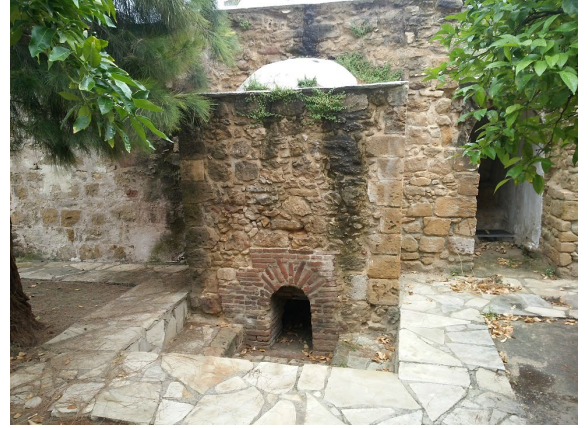
Foto. 22: Dragoman Hadjigeorgakis Konağı Hamamı, ocak ve su deposu.
