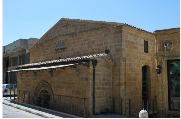
Foto. 1: Büyük Hamam, kuzey cephesi.
