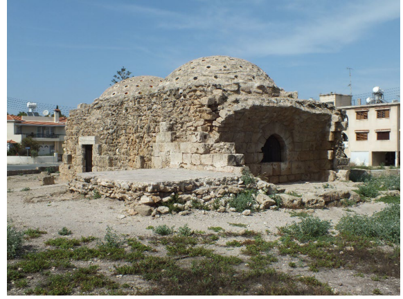
Foto. 39: Hasan Ağa Tekkesi Hamamı, güney ve batı cepheler.
