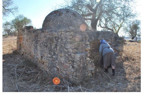
Foto. 33: Hisarköy Hamamı, su deposu.
