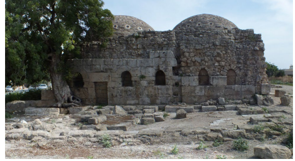
Foto. 37: Hasan Ağa Tekkesi Hamamı, kuzey cephe.
