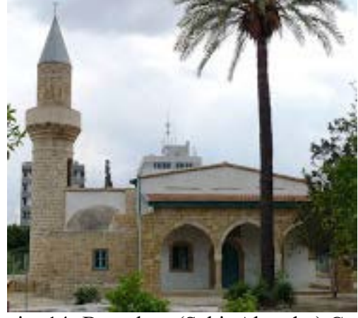
Resim 14- Bayraktar (Şehit Alemdar) Camii (Çağnan'dan)
