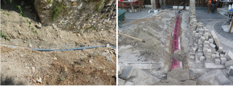
Foto. 16, 17: Yukarı Kale. Kanallara elektrik hattının döşenmesi işlemi (Kütahya Kalesi Kazı Arşivi)
