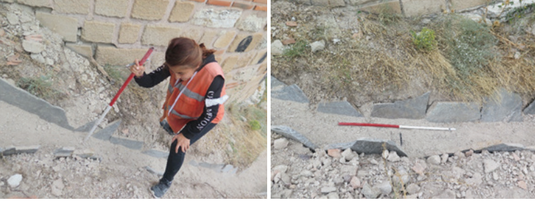
Foto. 14, 15: Yukarı Kale. Açılan kanalların doğal kayrak taşlarla sınırlandırılması (Kütahya Kalesi Kazı Arşivi)
