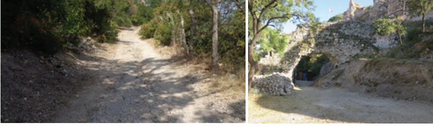
Foto. 20: Yukarı Kale Kuzeydoğu yolundaki temizlik çalışmaları (Kütahya Kalesi Kazı Arşivi)
