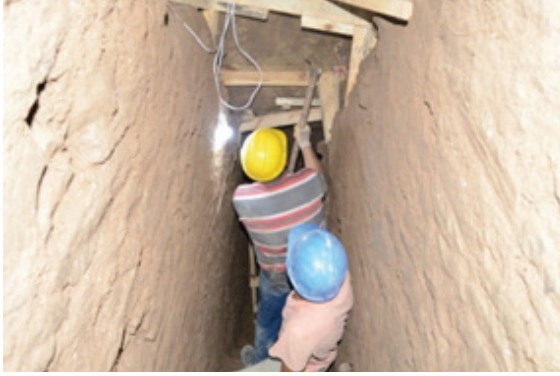
Fotoğraf 6: Kuyu ve merdivenli yapıda seviye inme çalışmaları ve tahkimat
