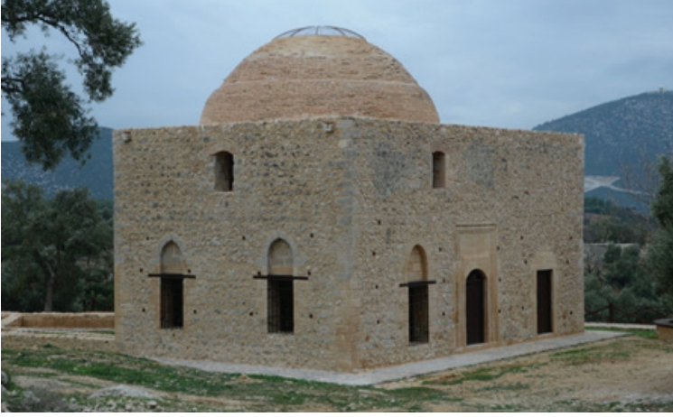
Fotoğraf 27: Yelli Camii restorasyon sonrası genel görünüm
