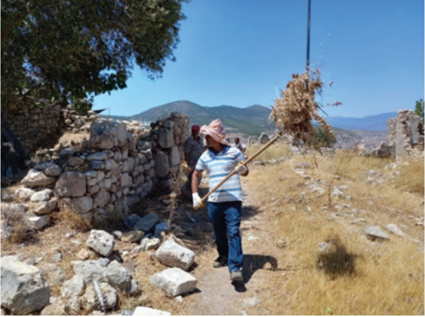
Fotoğraf 1: İç Kale'de yürütülen temizlik çalışmaları
