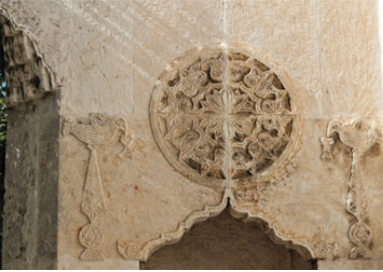
Foto. 34: El Sanatları müzesi, aydınlatma takası süsleme detayı. (orijinal)
