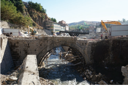
Resim 21: Ulu Cami köprüsünden görünüş.
