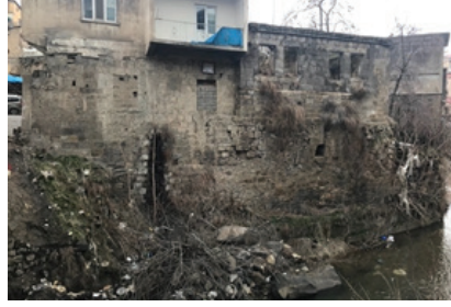
Resim 10: Aşağı Kale köprüsü güneyi surları.
