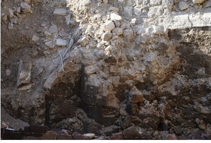
Resim 17: Pamukçular Köprüsü silindirik tahkimat.
