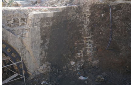
Resim 22: Ulu Cami köprüsünün dayandığı sur kalıntısı.
