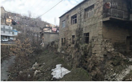
Resim 9: Aşağı Kale Camii'ne ulaşan surlar.
