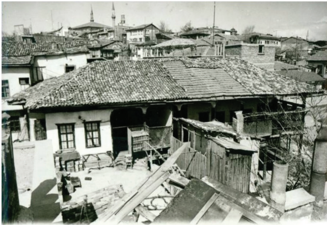
Şekil 3: Taşoda Konağı'nın 1976 yılına ait fotoğrafı (İstanbul Rölöve ve Anıtlar Müdürlüğü Arşivi'nden)
