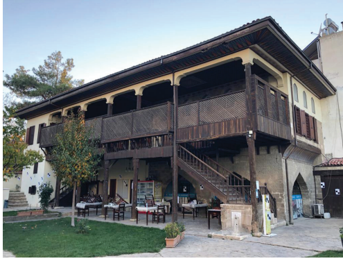
Şekil 7: Taşoda Konağı zemin katta avluya açılan mekânlar, merdiven ve çeşme
