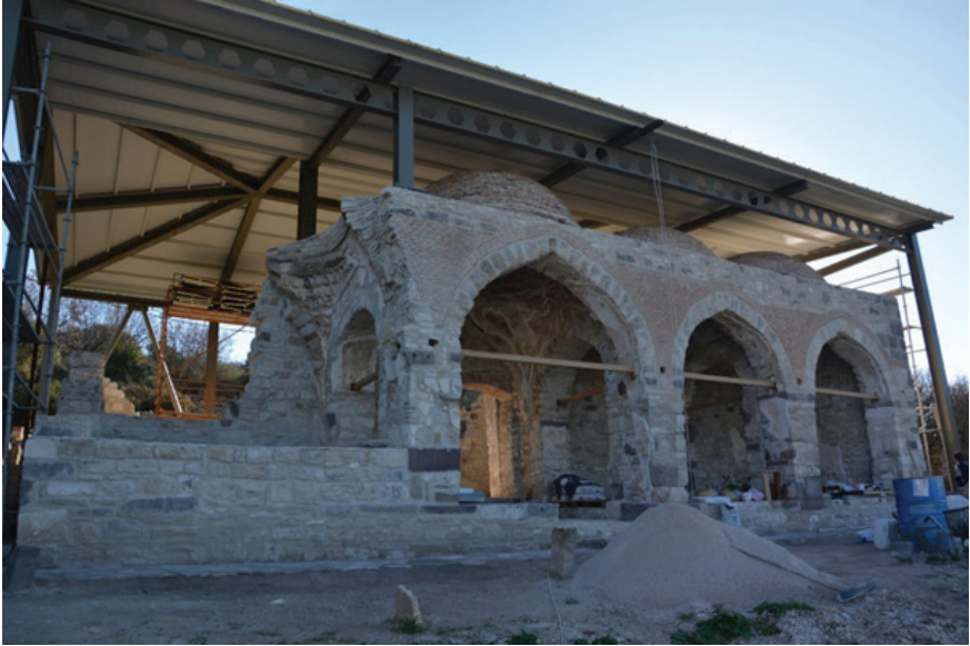
Fot.11- Eski Çeşme (İsmailobası) Köyü Camii. Konservasyon sonrası kuzeyden genel görünüş. (Aralık 2022).
