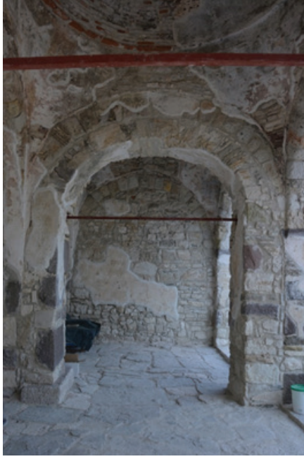
Fot.12- Eski Çeşme (İsmailobası) Köyü Camii. Konservasyon sonrası son cemaat yeri. (Aralık 2022).
