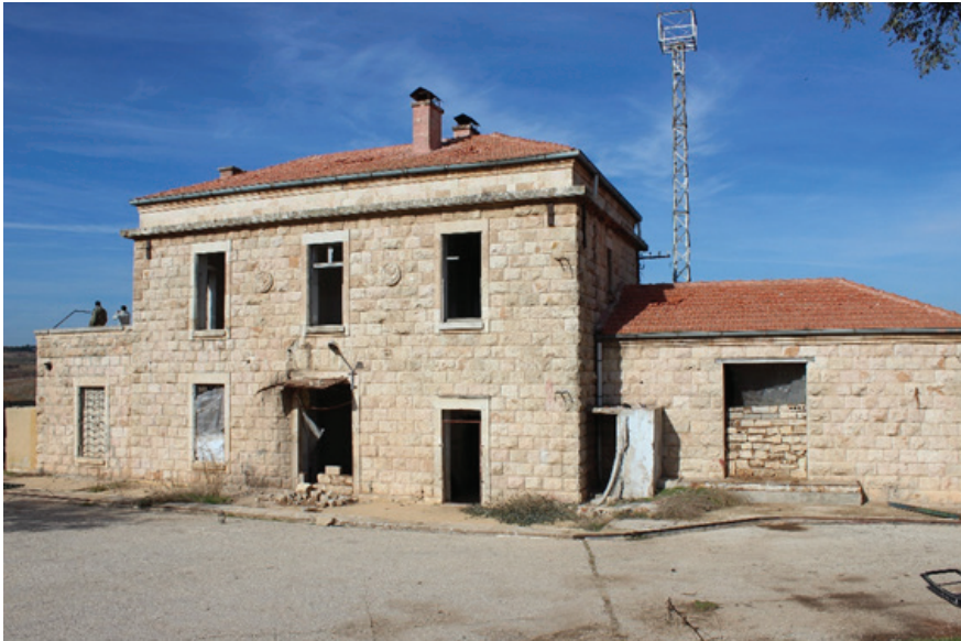
Görsel 6: Gar Binası Güney Cehesi (Kaynak: Çalışma Ekibi)
