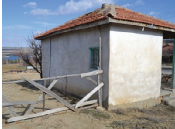
Foto 3: Batı ve Güney Cephesi
