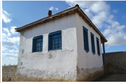
Foto 29: Odanın Doğu Cephesi
