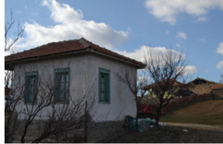
Foto 2: Doğu ve Kuzey Cephesi
