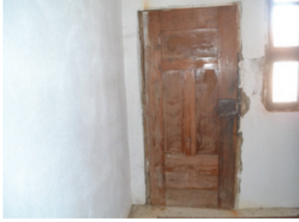
Foto 32: Aralık Mekânı Giriş Kapısı
