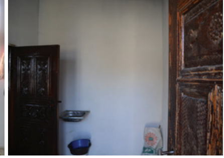
Foto 33: Aralık Mekânı Güney Cephe ve Oda Mekânına Giriş Kapısı
