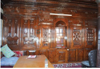
Foto 36: Oda Mekanı Güney Cephe
