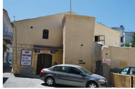
Foto. 17: Korkut Hamamı, doğu cephe.
