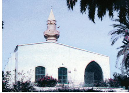
Resim 25- Pîrî Paşa (Minareli) Camii (DİA'dan)
