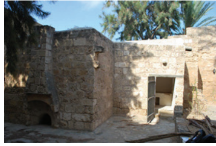
Foto. 34: Şömineli Ev Hamamı, doğu cephe.
