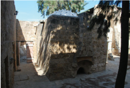
Foto. 35: Şömineli Ev Hamamı, ocak ve yaşamak.
