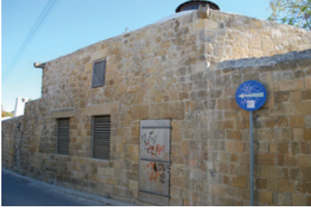
Foto. 5: Ömerge Hamamı, kuzey girişi.
