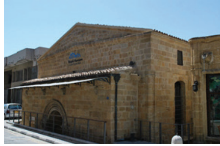
Foto. 1: Büyük Hamam, kuzey cephesi.
