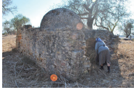
Foto. 33: Hisarköy Hamamı, su deposu.
