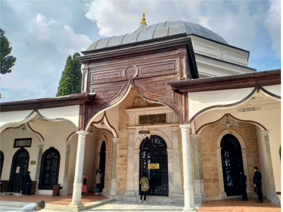
Fotoğraf 14: Emir Sultan Türbesi'nin dış cephesi (Eser Çalikuşu, 2023)
