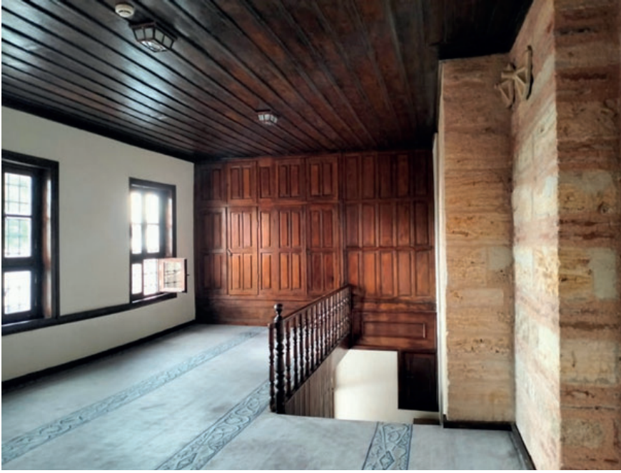
Fotoğraf 11: Emir Sultan Camii'nin son cemaat yerinin üzerindeki asma kat (Eser Çalığıuşu, 2023)
