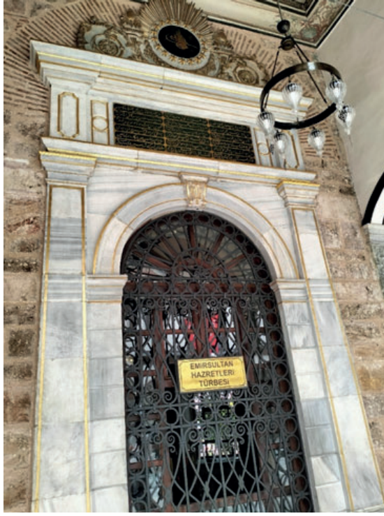
Fotoğraf 15: Emir Sultan Türbesi'nin ziyaret penceresinin üzerindeki kitabesi (Eser Çalikuşu, 2023)
