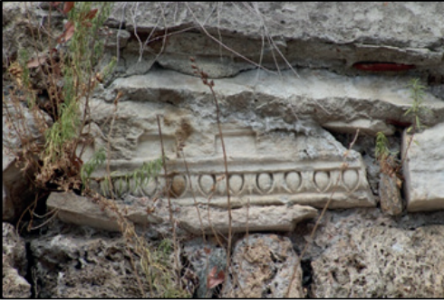
Resim 14: Fetih Kapı yakınındaki korniş.
