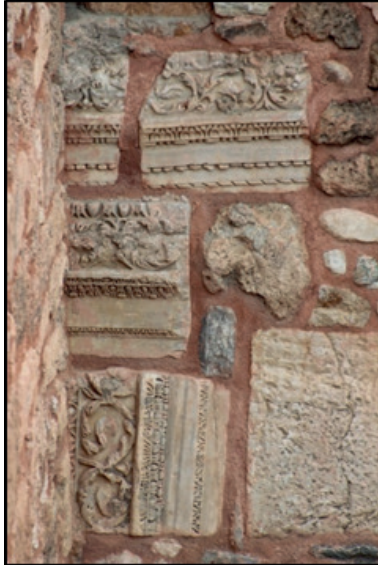
Resim 10: Zindan Kapı'daki arşitrav-friz blokları.
