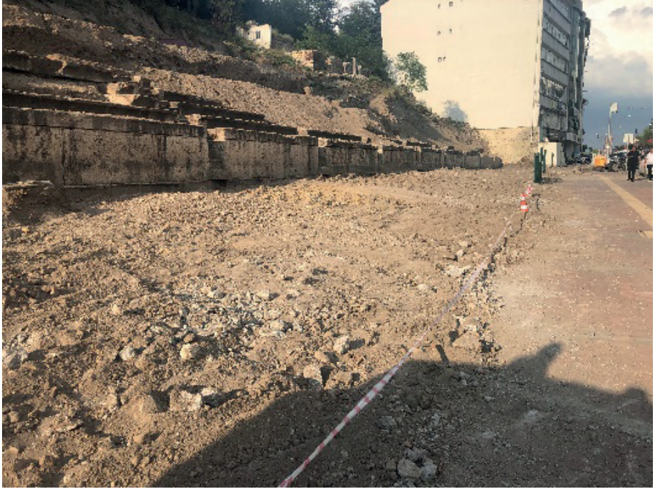
Resim 5: Balustrat duvarı önündeki duvar temelleri kaldırıldıktan sonraki görünüm
