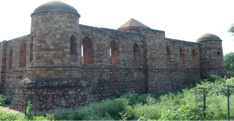
Foto. 2: Sultan Ghari Türbesi, Batı Cephe
