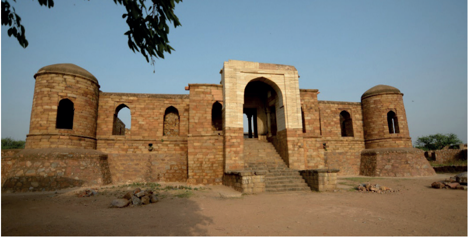
Foto. 1: Sultan Ghari Türbesi Genel Görünüş
