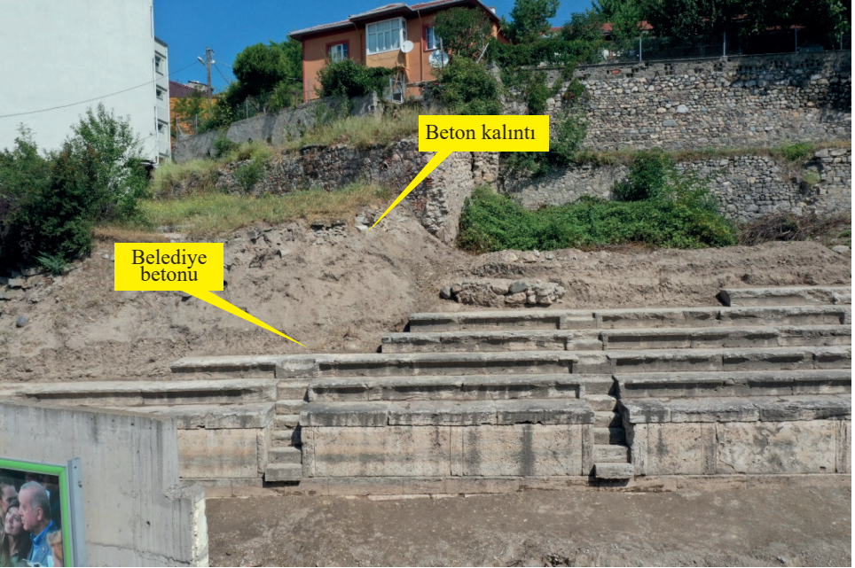
Resim 3: Oturma sıraları, beton kalıntı ve belediye betonu
