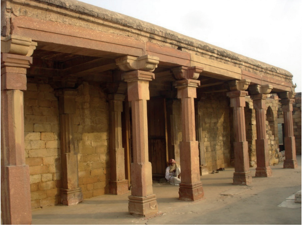
Foto. 8: İç Mekân, Doğu Duvarı Revak Düzenlemesi
