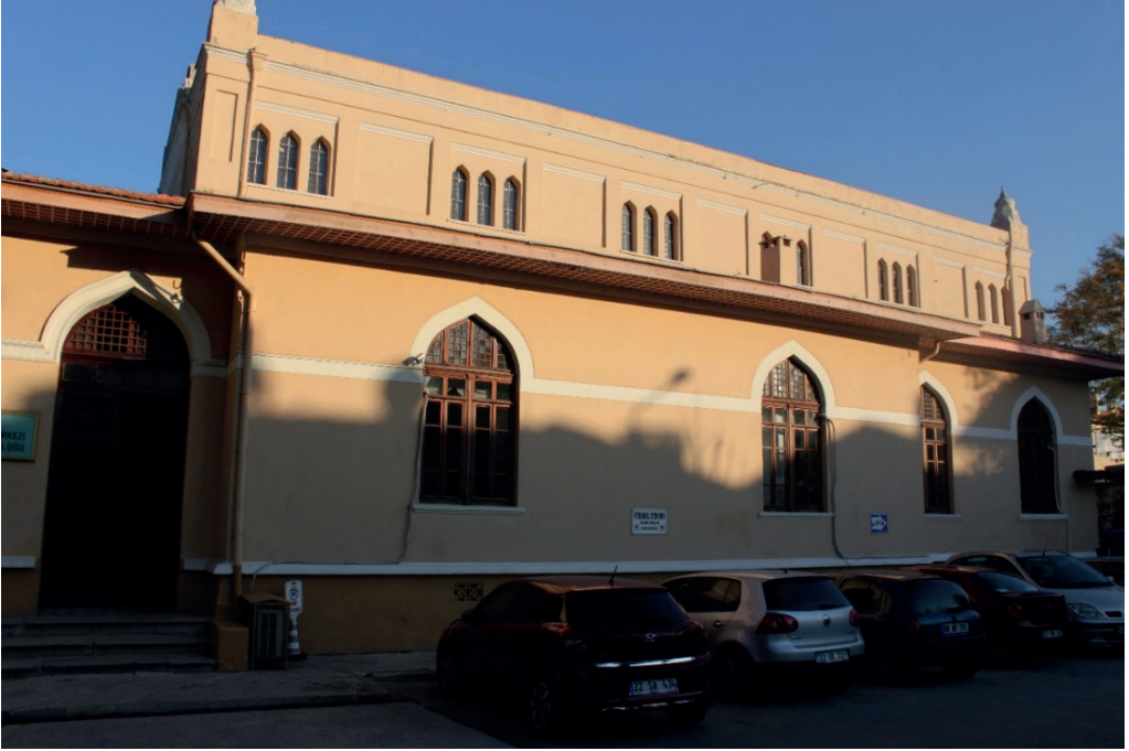
Fotoğraf 9: İttihat ve Terakki Kulübü Binası Batı Cephesi
