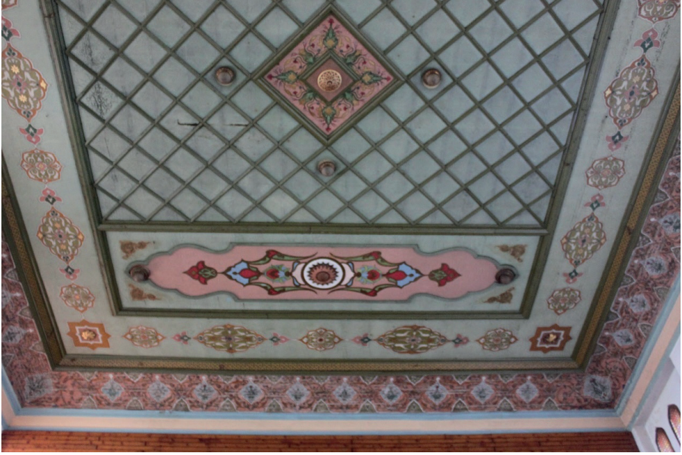
Fotoğraf 20: İttihat ve Terakki Kulübü Binası Salon Tavan Detayı
