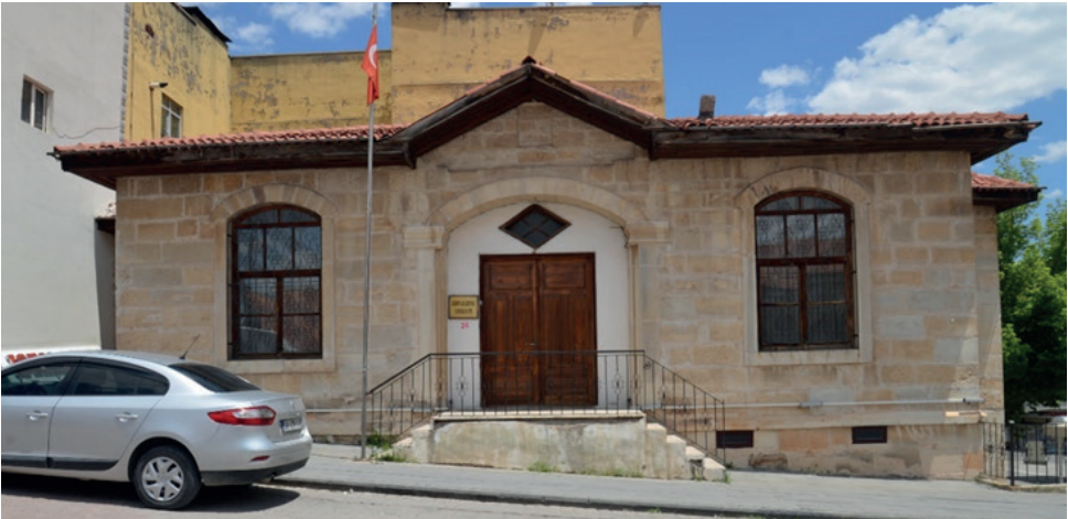
Fotoğraf 5: Gürün Rüştüyesi güneybatı cephe (Hacer Zor Akın, 2022)
