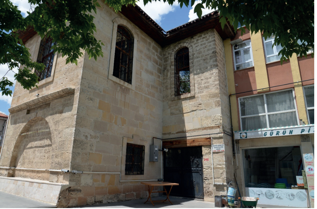
Fotoğraf 6: Gürün Rüştıyesi güneydoğu cephe (Hacer Zor Akın, 2022)
