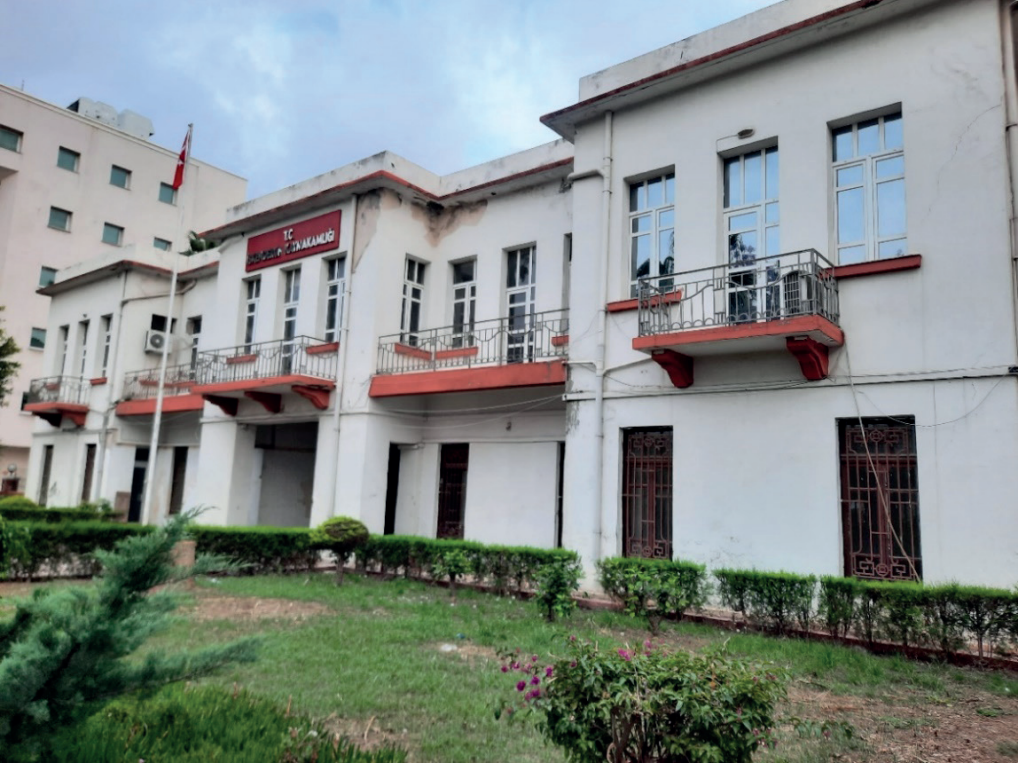
Görsel 10: İskenderun Hükümet Konağı Kuzey Cephe (M. Çiftiyürek, 2023)
