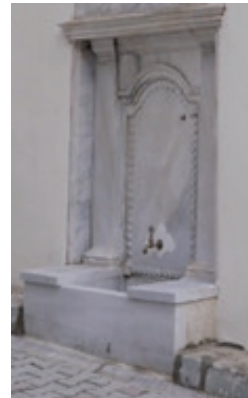
Resim 18. Çeşmenin restorasyon sonrası eklenen yalak ve musluğu
