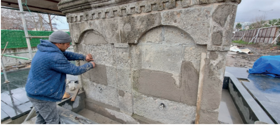
Şekil 3.12. Tarihi Alemdarzade Çeşmesinin derz uygulamaları (Sarılioğlu, 2024)
