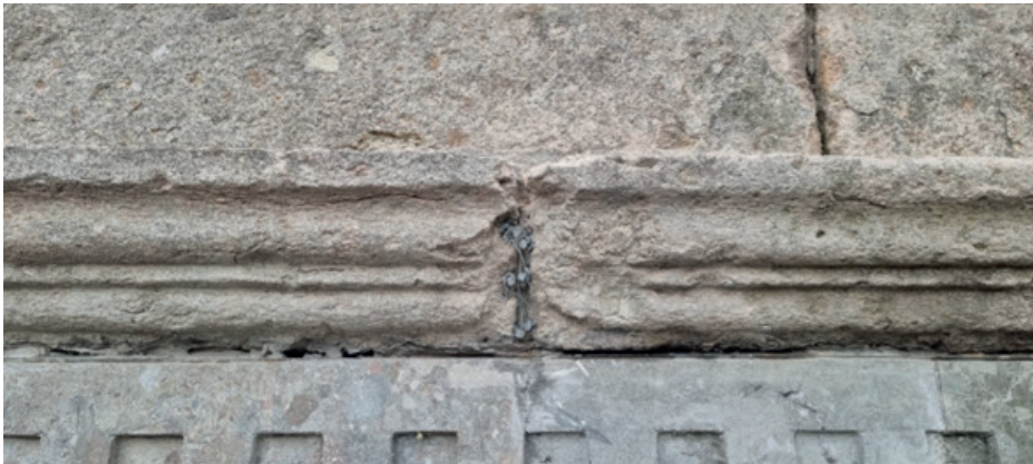
Şekil 3.13. Tarihi Alemdarzade Çeşmesinin plastik onarım örnekleri (Sarılioğlu, 2024)
