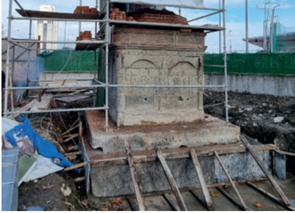
Şekil 3.22. Tarihi Alemdarzade Çeşmesinin yeni konumuna indirilmesi (Sarılioğlu, 2024)
