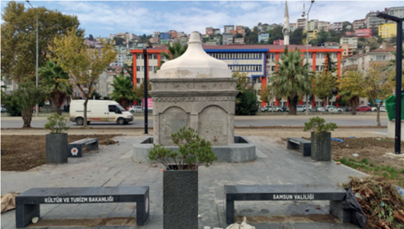
Şekil 3.26. Çeşmenin peyzaj ve altyapı çalışmalarının tamamlanması (Sarialioğlu, 2024)
