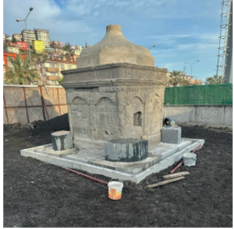
Şekil 3.11. Tarihi Alemdarzade Çeşmesinin temizlik çalışmaları (Sarılioğlu, 2024)
