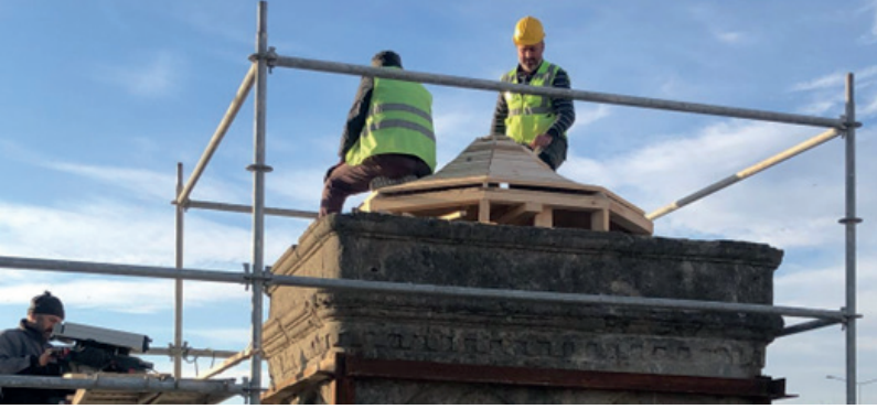
Şekil 3.17. Tarihi Alemdarzade Çeşmesinin orijinal kubbe yapımı (Sarılioğlu, 2024)
