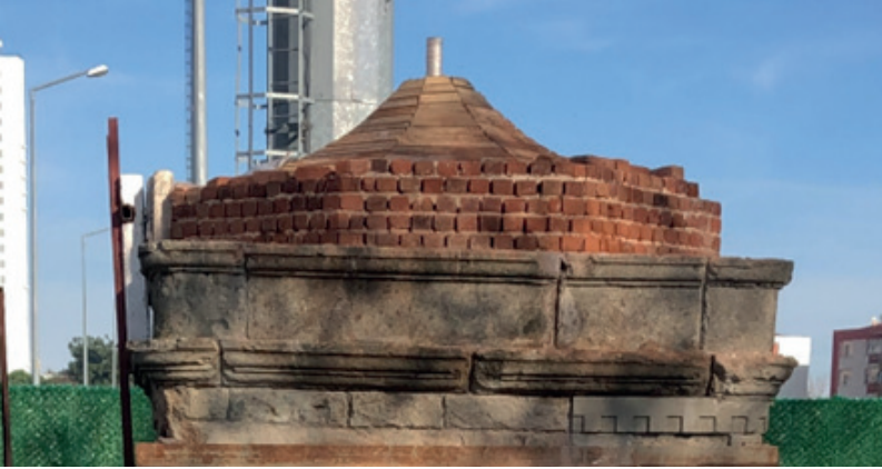
Şekil 3.18. Tarihi Alemdarzade Çeşmesinin orijinal kubbe yapımı (Sarılioğlu, 2024)
