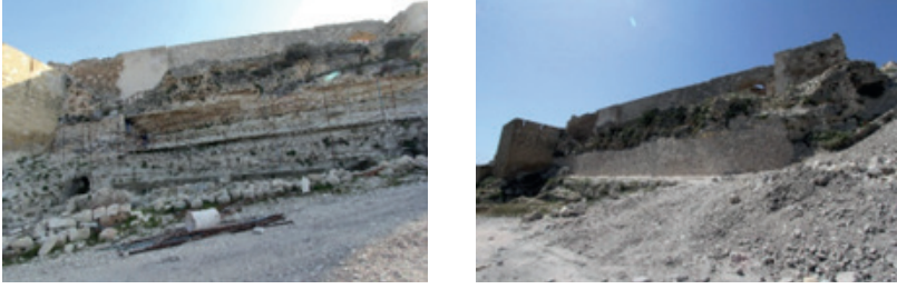
Resim: 7 – Restorasyon Projesi Kapsamında Ana Kaya Sağlamlaştırma Çalışması Öncesi Ve Sonrası
