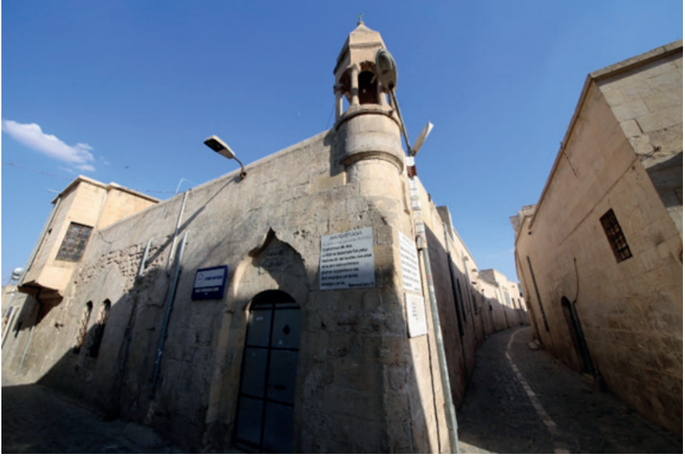
Foto. 41. Şanlıurfa Hacı Yadigar (Kuttik) Camii
