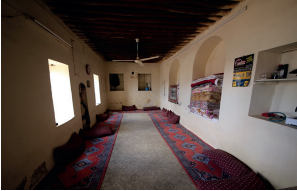
Foto. 48. Şanlıurfa Sayburç Köy Odası İç Kısım - Mihrap
