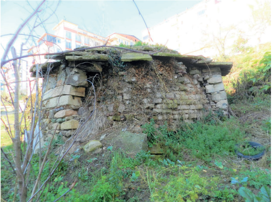
Fotoğraf 3. Çömlek fırınının doğu cephesi
