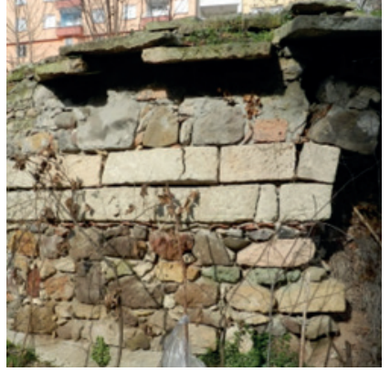
Fotoğraf 9. Çömlek fırınının duvar ayrıntısı
