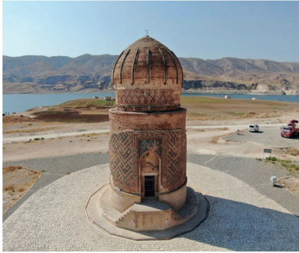
Şekil 15: Hasankeyf Zeynel Bey Türbesi ( http://www.hasankeyf.gov.tr/zeynelbeyturbesi/ )
