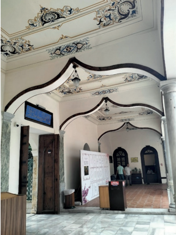
Fotoğraf 12: Emir Sultan Camii'nin kaş kemerli ve bağdadi tekniğindeki revakları (Eser Çalığıuşu, 2023)
