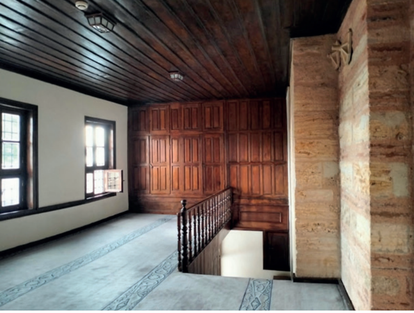
Fotoğraf 11: Emir Sultan Camii'nin son cemaat yerinin üzerindeki asma kat (Eser Çalığıuşu, 2023)
