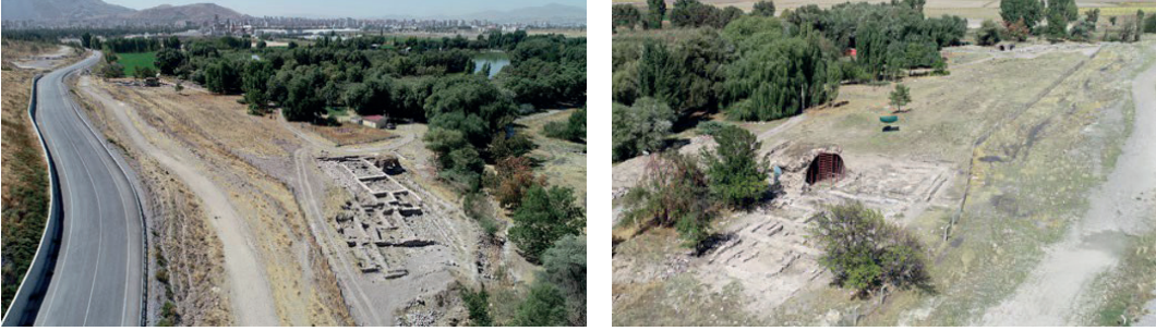
Görsel 1-2: Dört Kemerli ve Tonozlu Yapı Genel Görünüm
