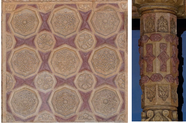
Görsel 11-12: Divriği Türan Melek Şifahanesi Taçkapısında kullanılan kakma tekniğinin uygulandığı atki taşı ve denge sütunu.
