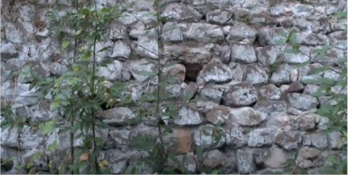
Görsel 20. Fatsa Kaleönü Kalesi Duvar Yapısı (2023)
