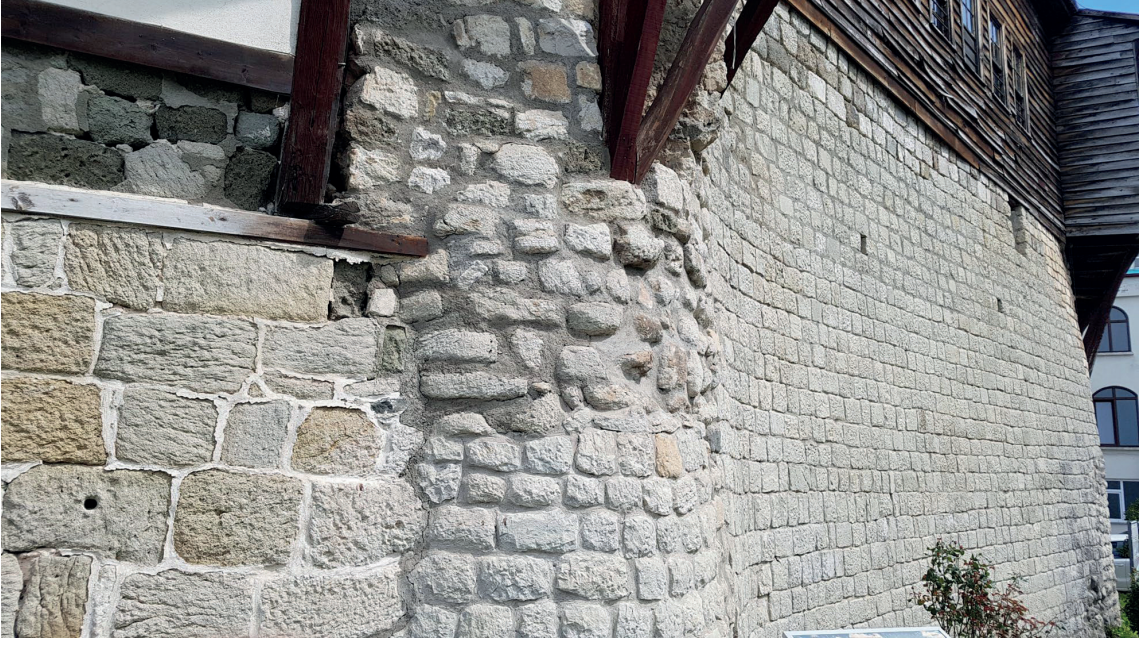
Görsel 17. Bolaman Kalesi, Duvar Yapısı (2023)
