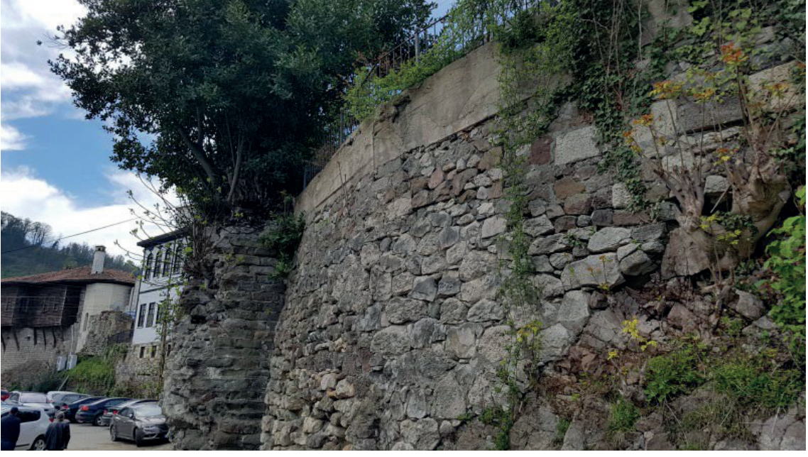
Görsel 19. Bolaman Kalesi, Duvar Yapısı (2023)
