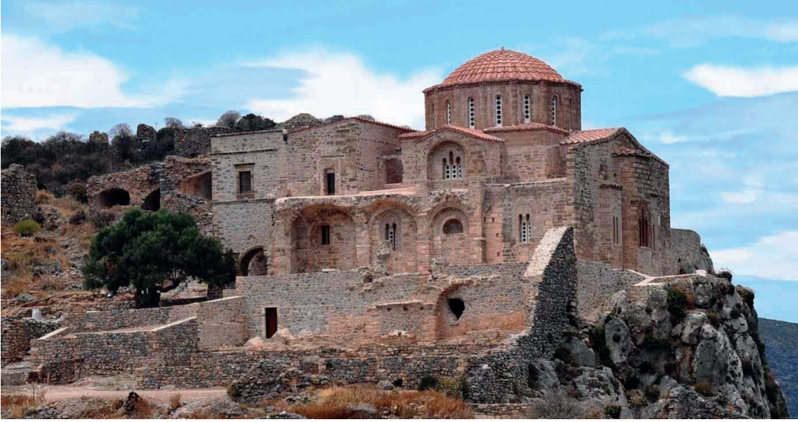
Görsel 19. Güney Cephe
