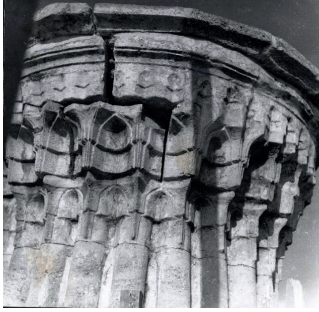
Görsel 17: İstanbul Burmalı Mescid'in Minaresinin 1961'deki Onarımı Esnasındaki Görünümü (Kaynak: Vakıflar İstanbul I. Bölge Müdürlüğü Arşivi)
