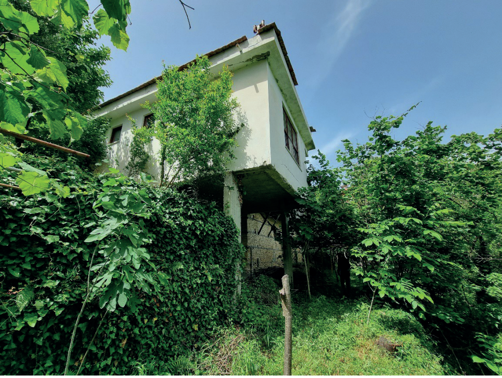
Görsel. 17 Geleneksel Konutta Betonarme Eklenti (Envanter No: 16)
