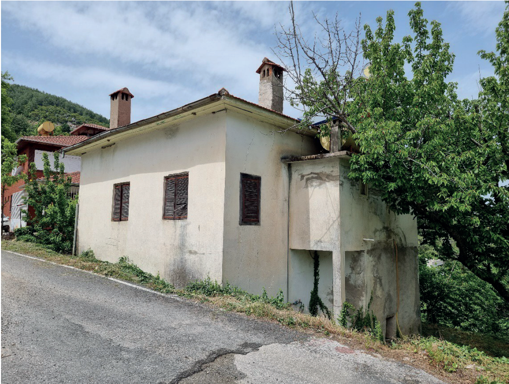
Görsel. 14 Sıvalı Cephe ve Baca Sistemi (Envanter No: 1)
