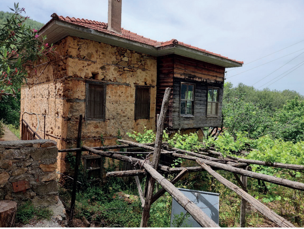
Görsel. 15 Kireç Harcı Sıva ve Ahşap Cumba Sistemi (Envanter No: 6)
