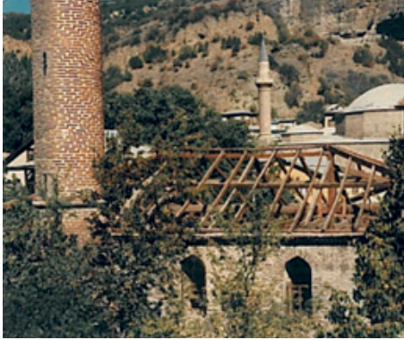
Görsel 29 1985 Tarihli Onarım Sırasında Çatı Aktarımı (VGM Arşivinden)
