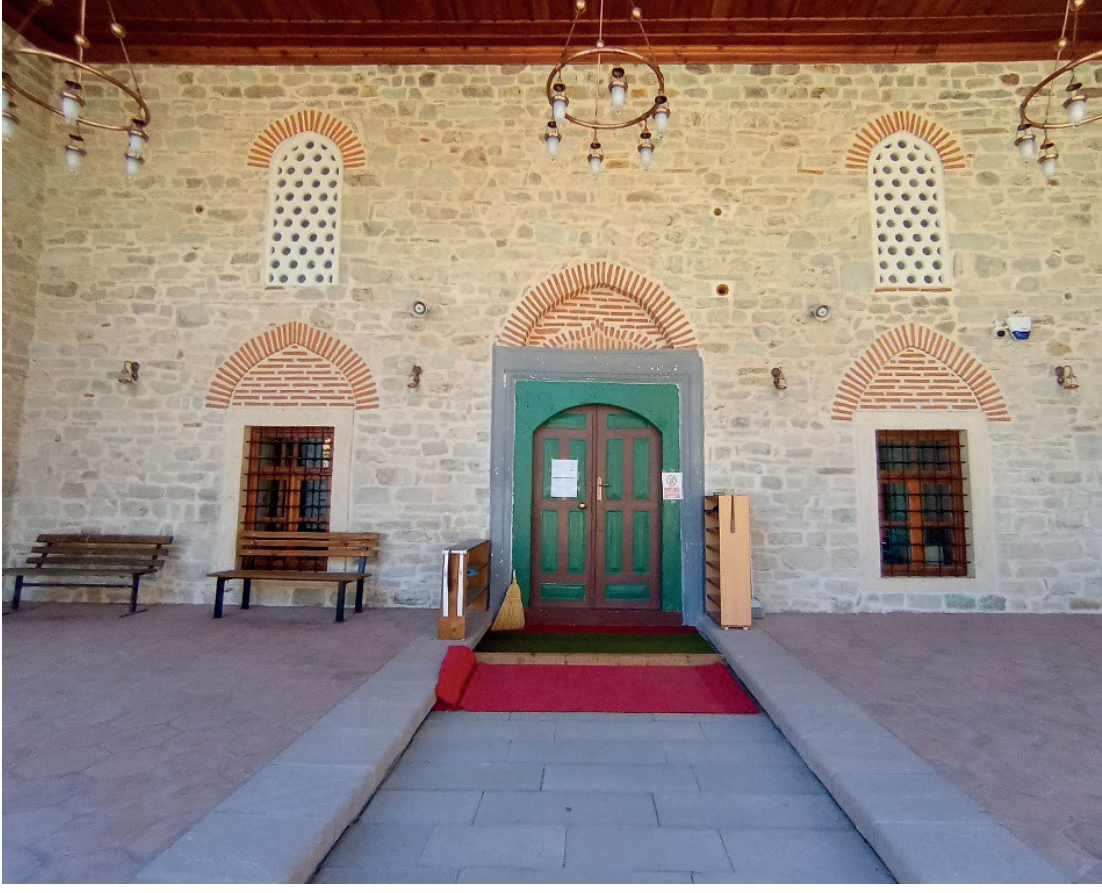
Görsel 15: Son Cemaat Yeri Kuzey Duvarı ve Cümle Kapısı (V. ESEN, 2024)
