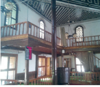
Görsel 35: Güneydoğu Yönden Ahşap Mahfil Görünüşü (A Proje Restorasyon'dan)
