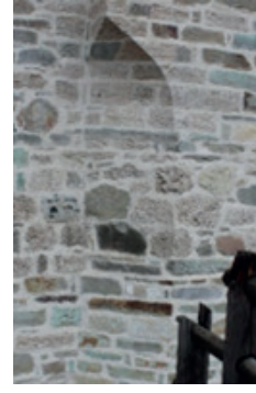
Görsel 8 Son Cemaat Kısmı Güneydoğu Köşesi (V. ESEN, 2024)
