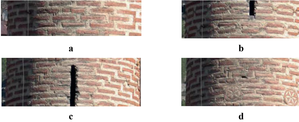
Görsel 13: Minare Gövdesinde Uygulanan Tuğla Dizim Örnekleri (V. ESEN, 2024)
