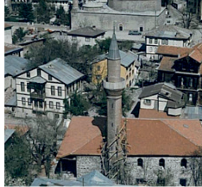
Görsel 30 1985 Tarihli Onarım Sırasında Minare Onarımı (VGM Arşivinden)
