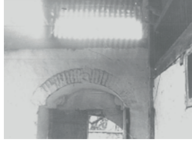
Görsel 32: Odamın Kuzey Duvarının Bir Kısım ve Pencere Açıklığı Görünüşü (VGM Arşivinden)
