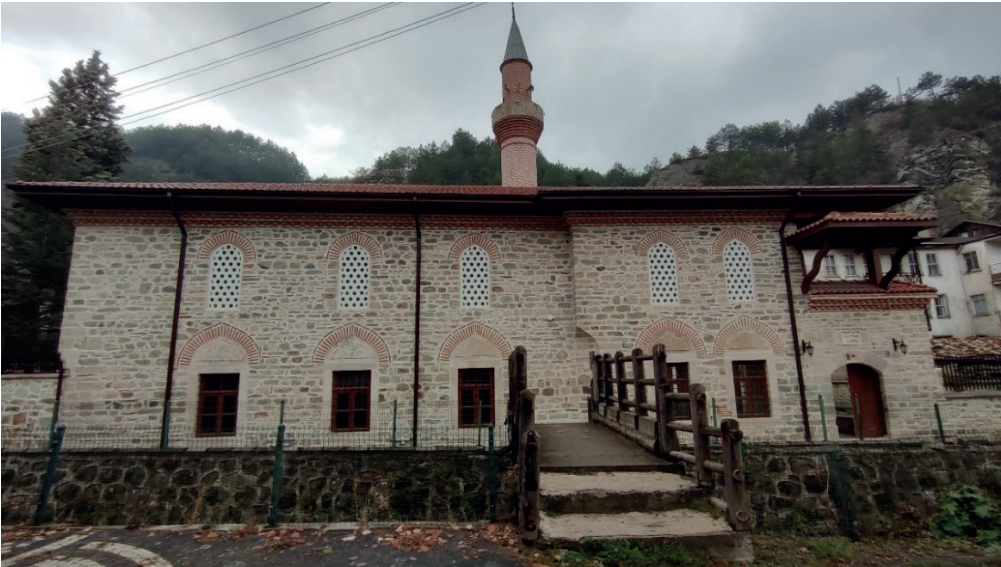
Görsel4 Doğu Cephe Görünüşü (V. ESEN, 2024)
