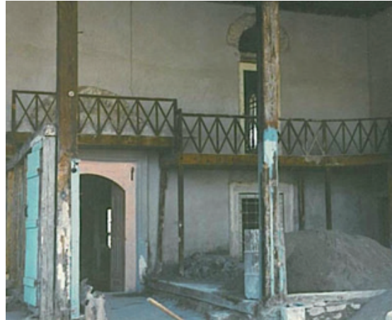
Görsel 34: Oda Duvarları Yıkıldıktan Sonra Son Cemaat Yeri Görünüşü (VGM Arşivinden)
