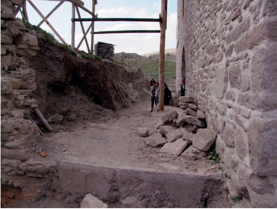
Görsel 12: Konya Sille Aya Eleni Kilisesi, kurtarma kazısı, Bizans yapı temelleri (Konya Kültür Varlıklarını Koruma Bölge Kurulu Müdürlüğü arşivi)
