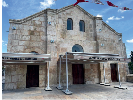
Görsel 4: Yapının doğu cephesinden görünüm (2024)
