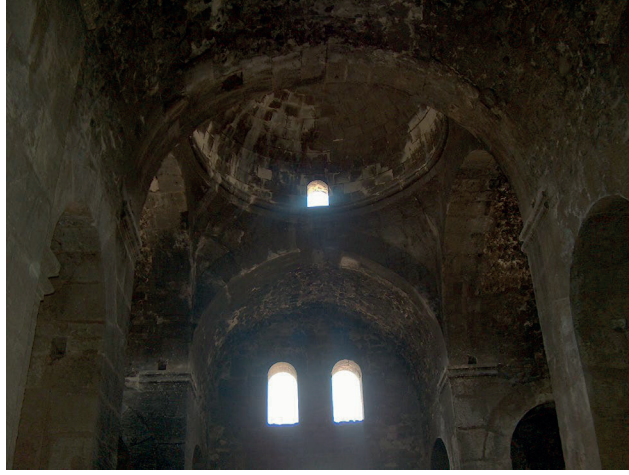
Görsel 24: Yapının 2000'li yılların başında batı cephesinden detay (VGM Arşivi)
