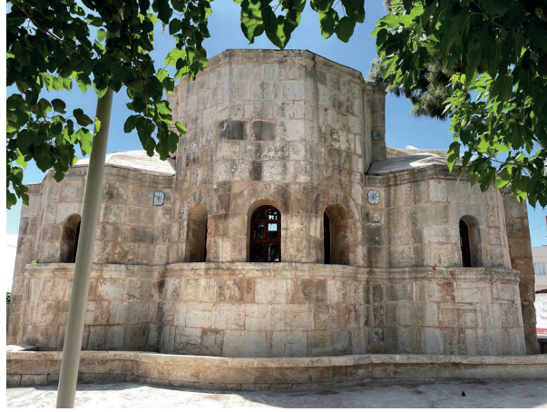
Görsel 6: Yapının Doğu Cephesinden Görünüm (2024)
