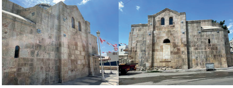
Görsel 5: Yapının kuzey ve güney cephelerinden görünüm (2024)
