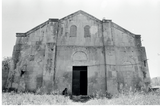
Görsel 15: Yapının 1984 yılında batı cephesinden görünüm (VGM Arşivi, Dosya No: 270601003-FT004)
