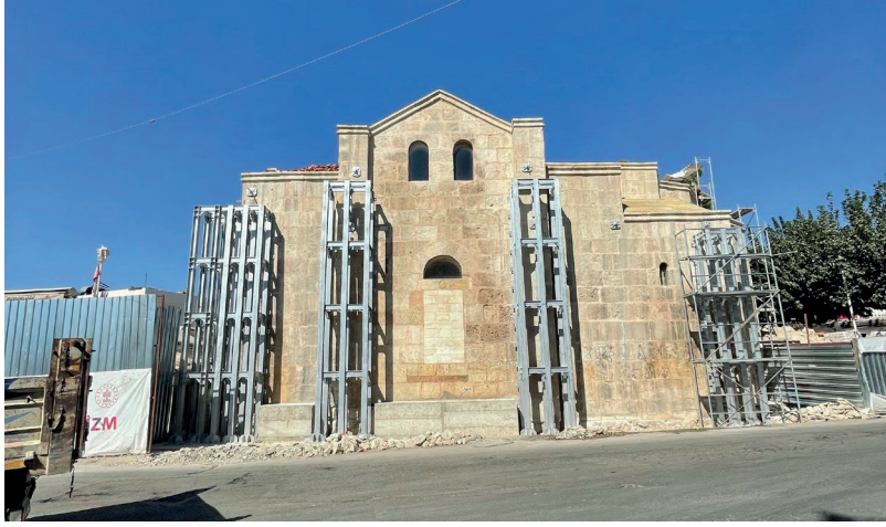
Görsel 28: Yapının son restorasyonunda güney cephesinden detay (2024)
