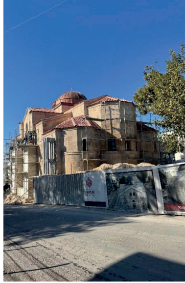
Görsel 29: Yapının son restorasyonunda eklenen kiremit malzeme ve bakır kubbe detayı (2024)
