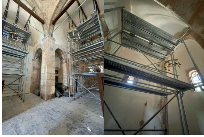
Görsel 9: Yapının kuzeydoğu cephesinden ve prothesis odasından detay (2024).
