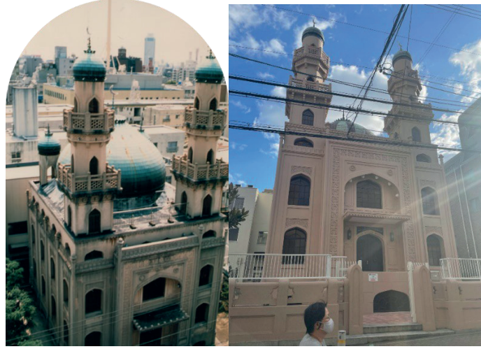
Görsel 6: Kobe Cami Portal Görünüşü
