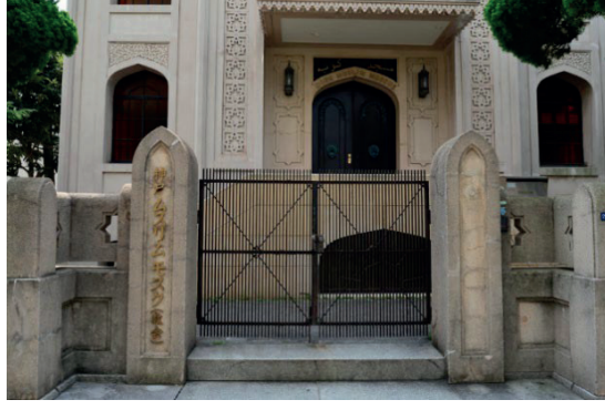
Görsel 8: Avlu Duvarındaki Kitabeli Giriş Kapısı
