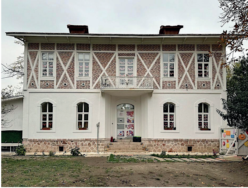
Görsel 54: Harir Darü't Tahsili binası, güney cephe genel görünümü (05.12.2023).
