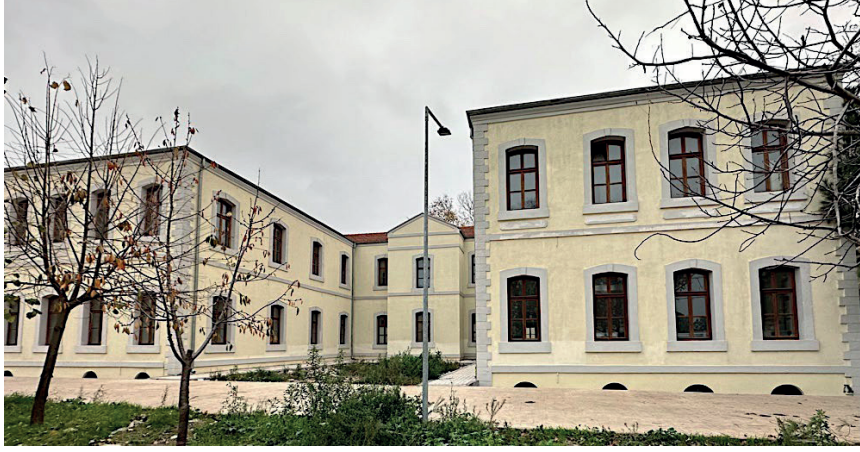
Görsel 47: Bursa Hamidiye Ziraat Mektebi, yatakhane binasının kuzey cephe görünümü (05.12.2023).
