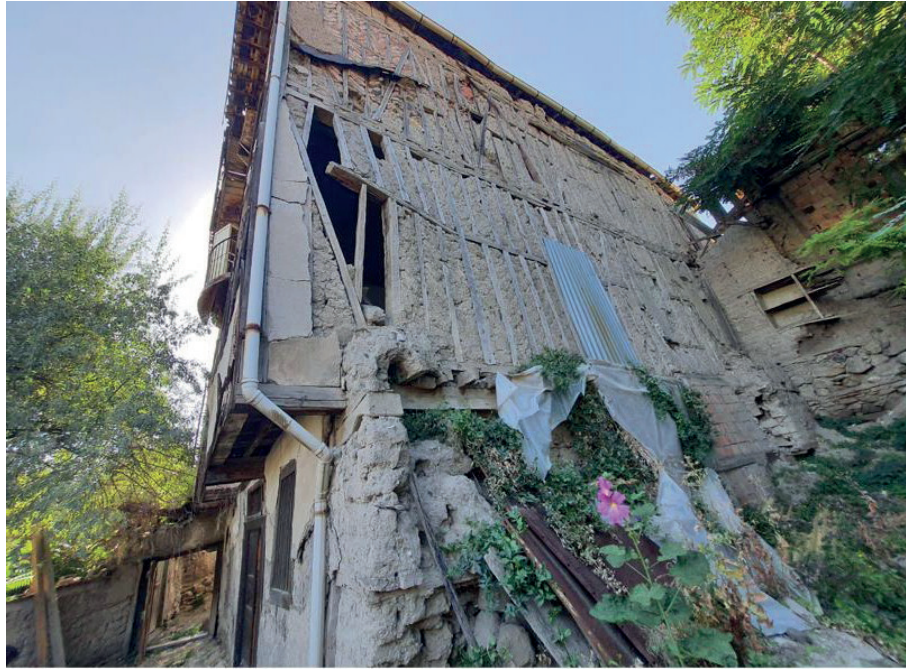
Batı Cephesi Görsel 18: (Sağiroğlu- Gündoğdu,2023)
