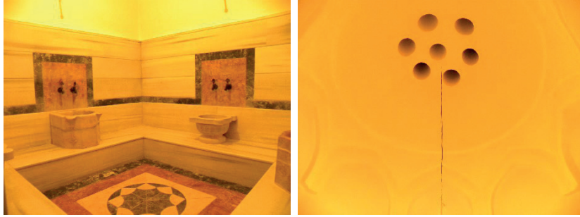
Görsel 175, 176: Güneybatı köşe halveti ve kubbesi
