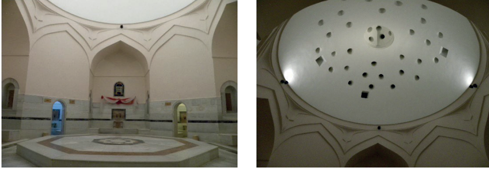
Görsel 169, 170: Sıcaklık bölümü ve kubbesi
