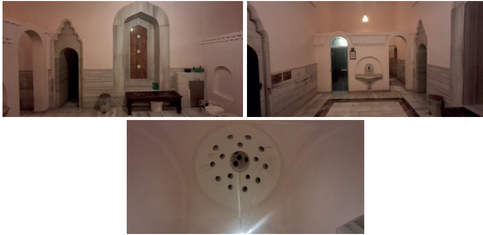
Görsel 144, 145, 146: Soğukluk bölümü batı ve güney cephe ve merkezdeki kubbe
