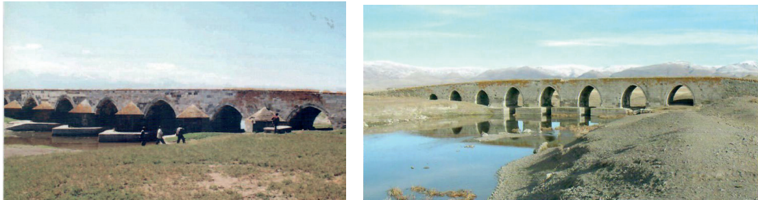
Görsel 34 8 , 35 9 : Köprü'nün 1980-84 onarım sonrası durumu
