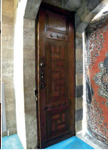
Görsel 53: Ahşap kapı kanadı
