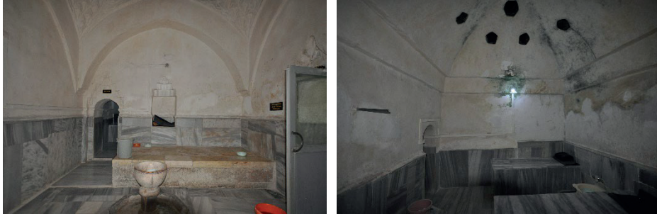
Görsel 85: Soğukluk güney cephe, seki ve Görsel 86: Keselik bölümü keselik girişi
