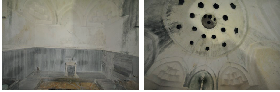
Görsel 98, 99: Güneybatı köşe halveti ve kubbesi
