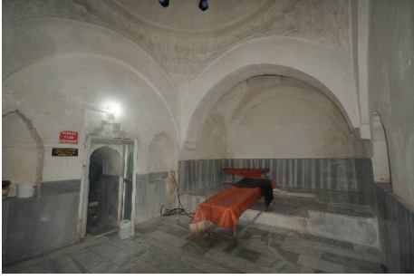
Görsel 108: Kuzeydeki birim ve tonoz örtüsü
