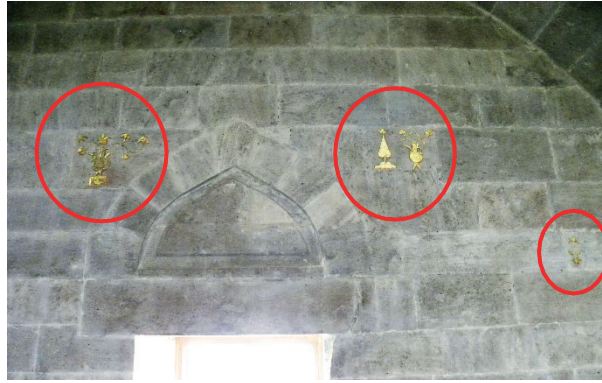
Görsel 63: Batı duvarı üzerindeki süslemeler
