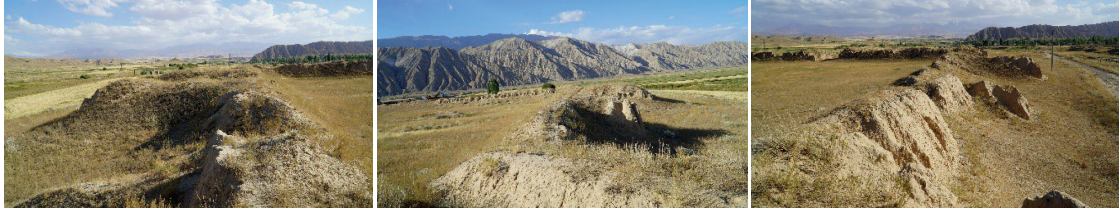
Görsel 12: Doğu surlarından güneye kuzeye bakış (sol/orta), Batı (Fırat KARA, 2022)
