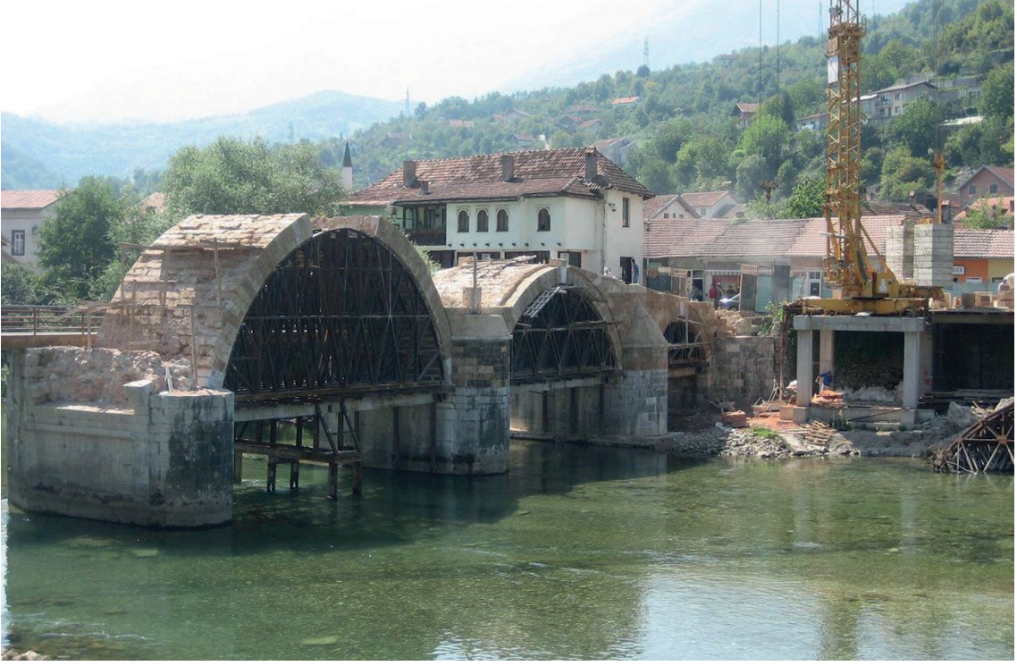
Görsel 37- Tarihi Konjic Köprüsü Restorasyon Çalışması (2009)
