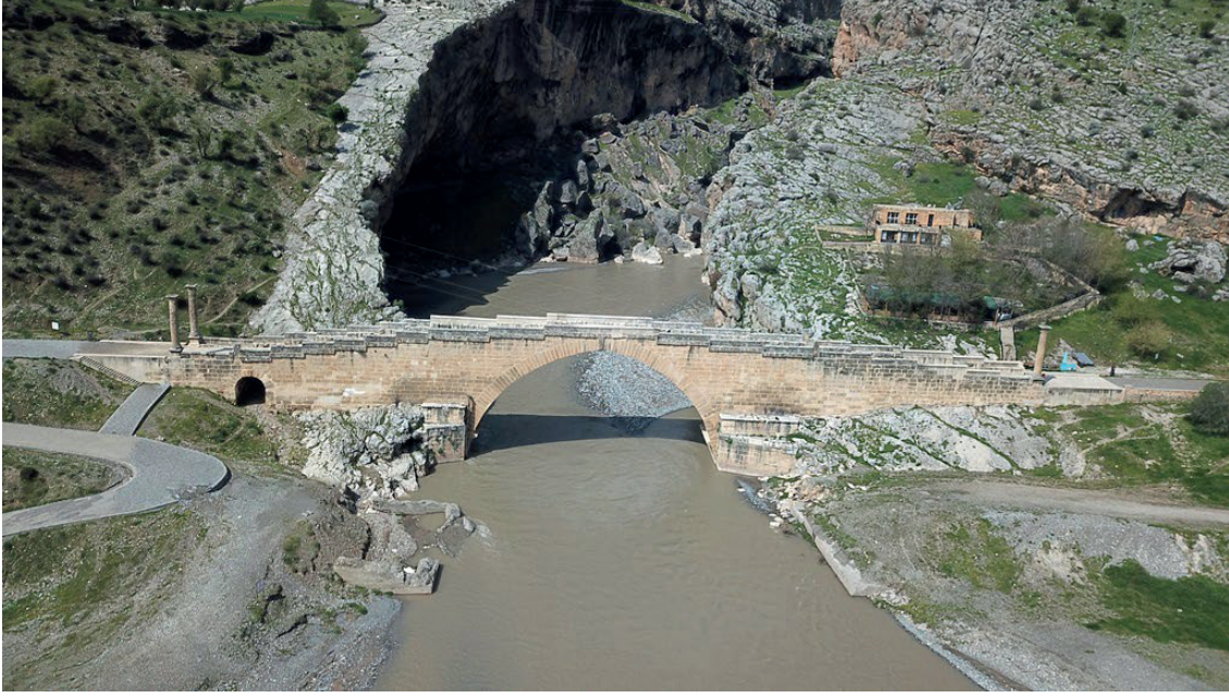
Görsel 4- Tarihi Cendere (Septimius Severus) Köprüsü mansap cephesi (KGM Arşiv 2024)
