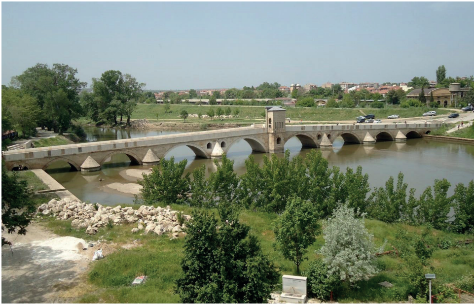
Görsel 32- Tarihi Ekmekçiöğlü Ahmet Paşa (Tunca) Köprüsü Mansap Cephesi
