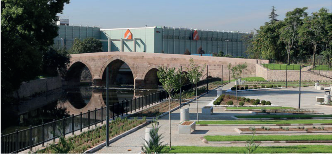
Görsel 13- Tarihi Akköprü Memba Cephesi
