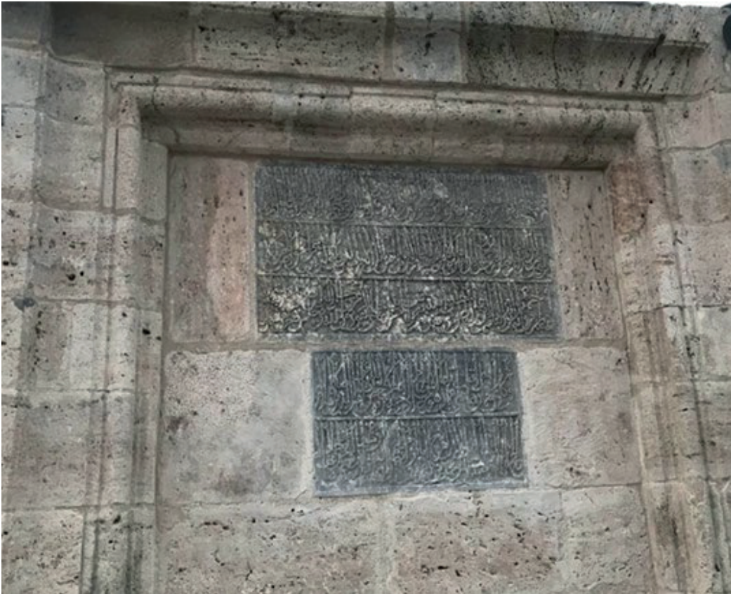
Görsel 22- Tarihi Hıdırlık Köprüsü'ne Ait Kitabe (Restorasyon Sonrası)
