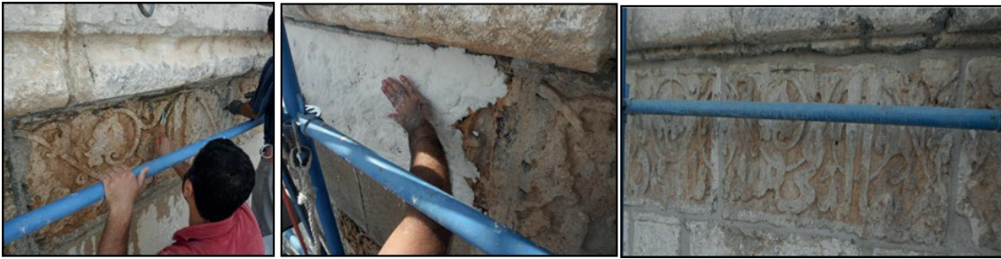
Görsel 10- Özgün Kitabede Yapılan Konservasyon Çalışmaları
