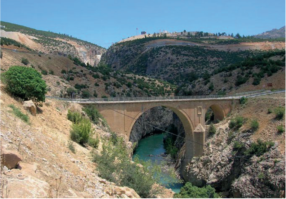
Görsel 23- Tarihi Görmeli (Ala) Köprüsü memba cephesi
