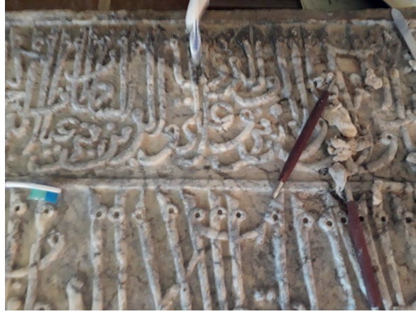
Görsel 21- Köprü Kitabesinde Yapılan Konservasyon Çalışmaları
