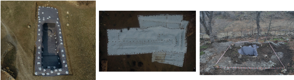
Görsel 45-47: Tonozlu Sarnıç, Kilise ve İşlik-1, Kazı Çalışmaları Sonrası Yapıların Jeotekstil ve Branda Serilerek Korunma Altına Alınması (Kazı Arşivi).
