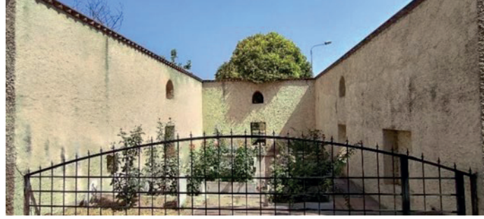
Görsel 67: Çandarlı Halil Paşa Türbesi Güney Cepheden Görünümü.
