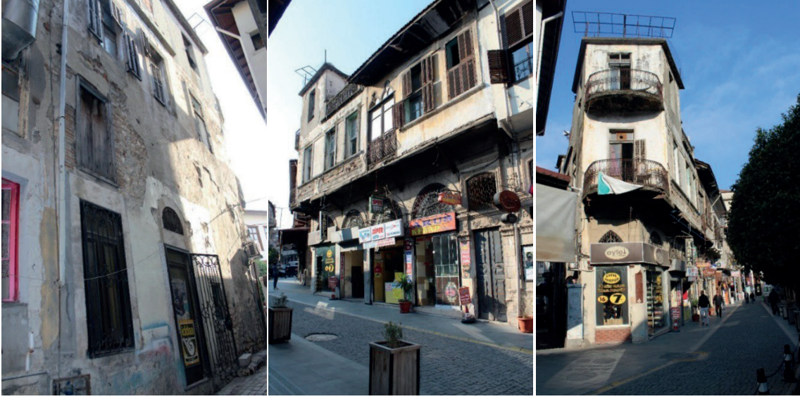
Görsel 2-3-4: Yapının Batı, Doğu ve Güney Cepheleri (Kaynak: M. Çiftiyürek)
