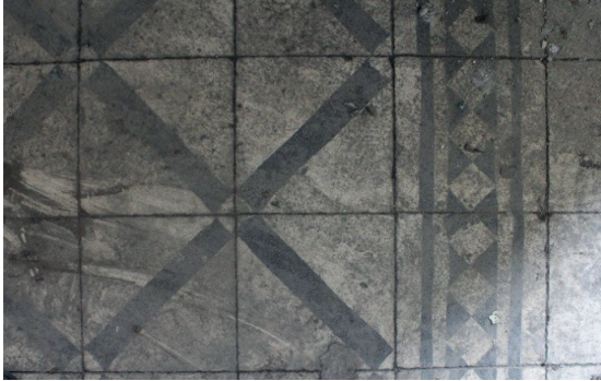
Görsel 30: Sofanın Kuzeydoğusundaki Oda Zemin Karoları (Kaynak: M. Çiftyürek)
