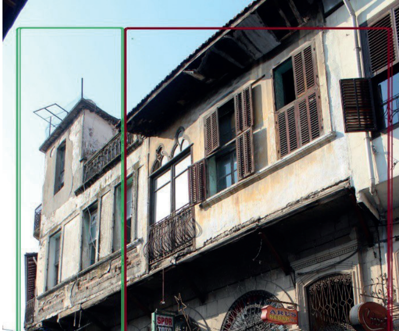
Görsel 39: Konutun Doğu Cephesi (Kaynak: M. Çiftiyürek)
