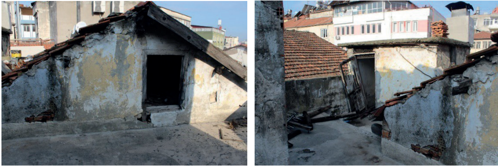
Görsel 21-22: Teras Çatı Bölümü ve Tuvalet- Banyo (Kaynak: M. Çiftiyürek)
