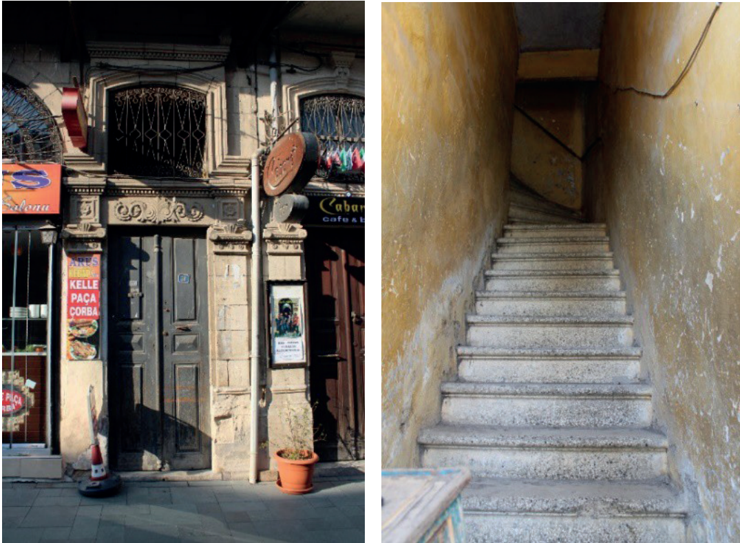
Görsel 7-8: Konut Giriş Kapısı ve Merdivenler (Kaynak: M. Çiftyürek)
