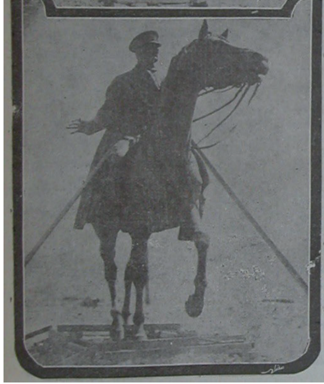
Görsel 28: Heykelin Kaide Üzerine Yerleştirilmesi (Hakimiyet-i Milliye)
